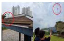
공원 내 파고라와 지붕 안전 점검
